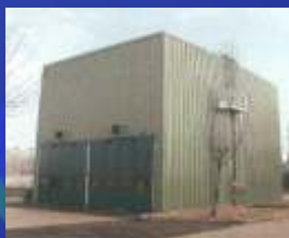
Silo na sůl 500t Mestre, Itálie
